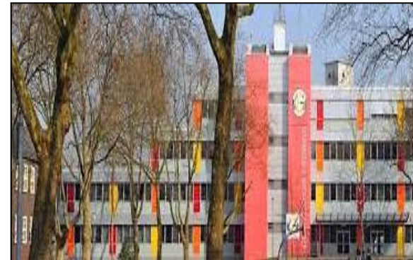
Gesamtschule Osterfeld in Osterfeld
